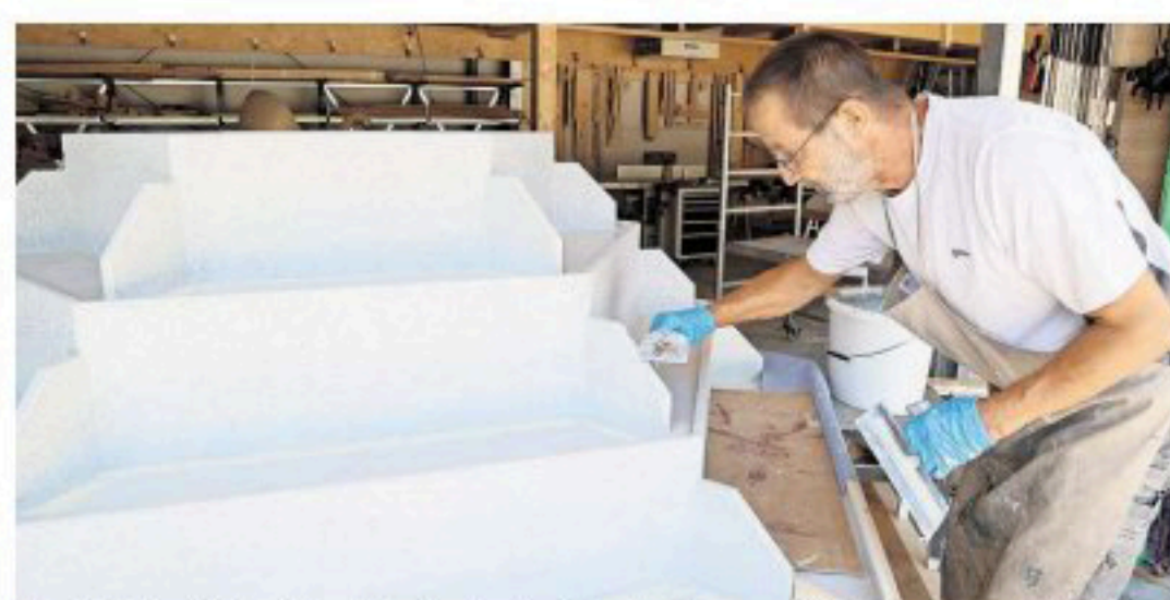
Uwe Roik bringt Putz auf den Holzunterbau des Schwalbenhauses auf. Der muss rau sein, damit die Mehlschwalben einen besseren Halt auf dem Putz finden.
